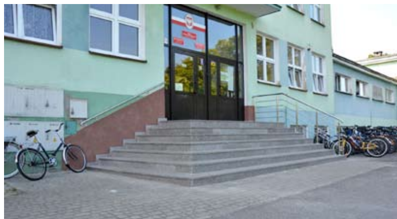
Wyremontowane schody przy ZPO nr 2
